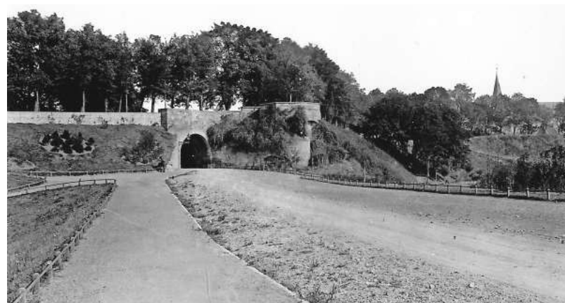
Die 1879 vom Verschönerungsverein errichtete Bastion am Neuen Hohnser Tor des Kehr wiederwalles, Fotografie um 1885 ARCHIV VERLAG GEBR. GERSTENBERG
