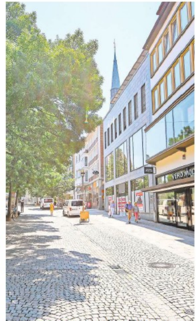
2019 ▲ Eine Straßenbahn fährt im Hohen Weg heute nicht mehr. Alle Häuser der Umgebung sind Nachkriegsbauten. FOTO: CHRIS GOSSMANN
